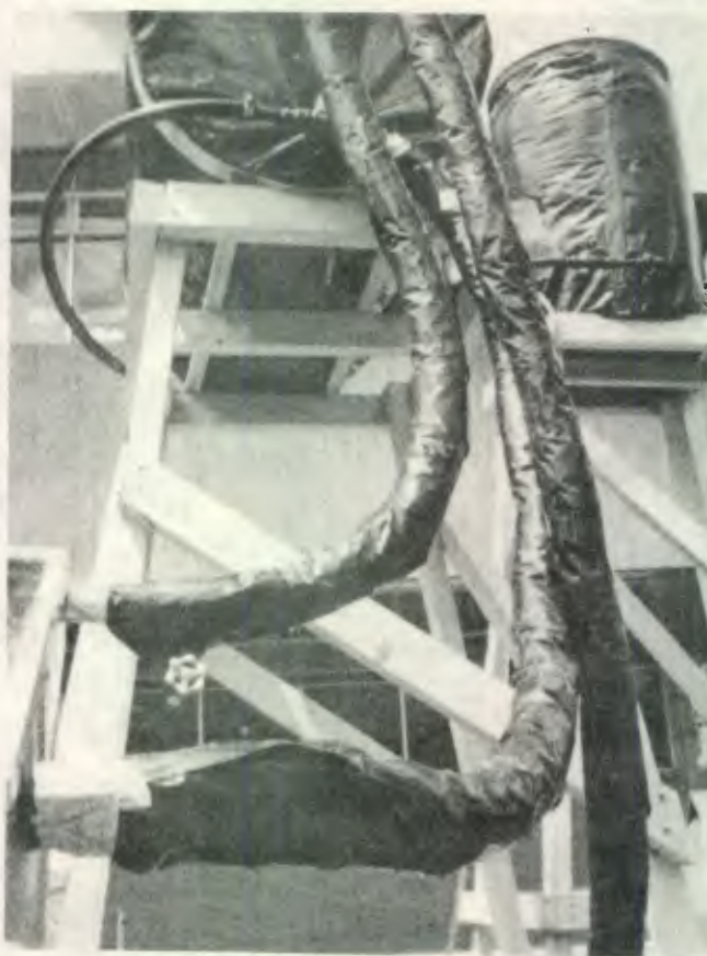
FIGURA 21 Vista de los acoples de la tubería aislada y las válvulas de control de paso de agua caliente hacia el Acumulador de Calor.
