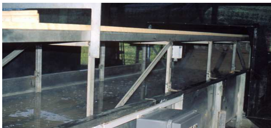
Figura 14. Pileta para el tratamiento hidrotérmico de la papaya. La fruta se sumerge en agua caliente para el control de la mosca
