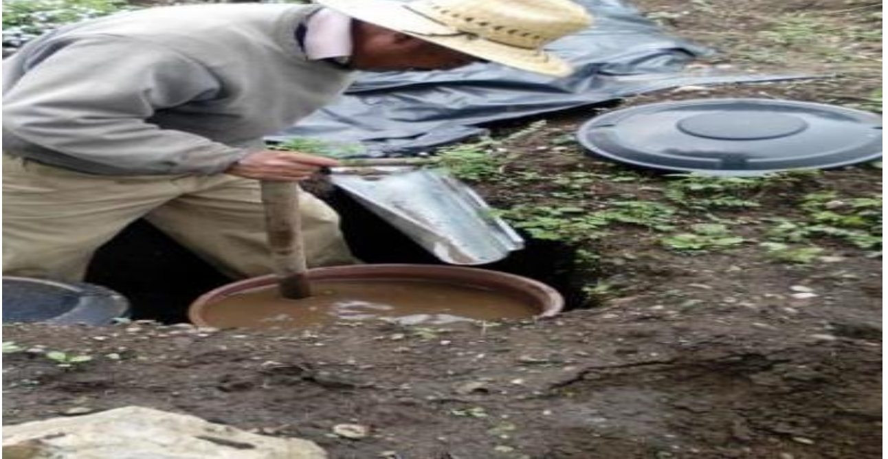
Figura 36. Sistema Colector funcionando luego de un evento de lluvia.
