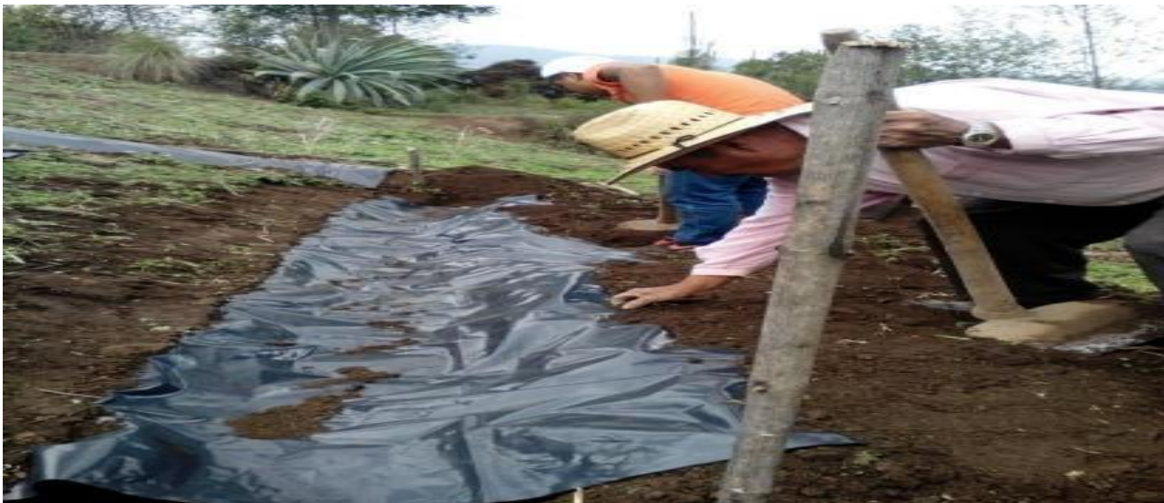
Figura 35. Sistema colector, canal colector cubierto con polietileno.
