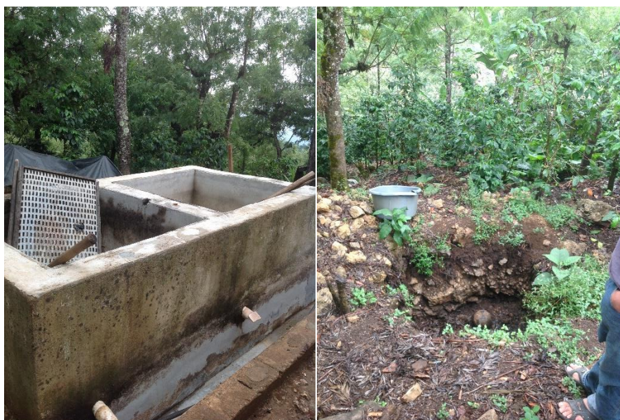
Figura 26A. Instalaciones de beneficio de los nuevos socios productores de café de ADIRSEC.
