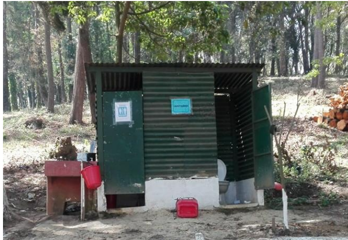
Figura 2. Fotografía de Sanitario
