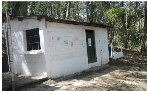
Figura 3. Instalaciones de Bodega
