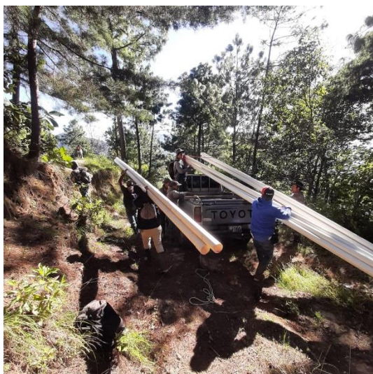
Figura 11A. Actividades desarrolladas por el proyecto de reparación del sistema de riego
