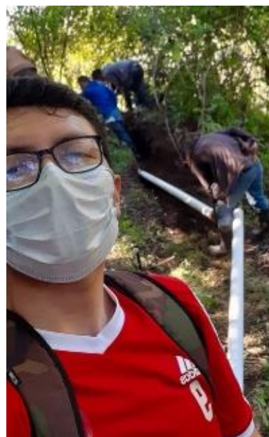
Figura 12A. Acompañamiento a la reparación del sistema de riego
