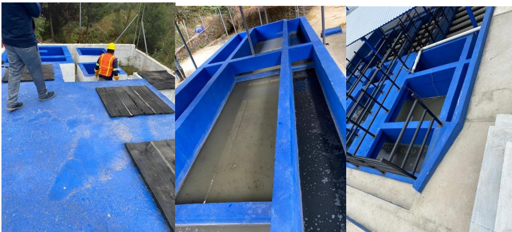
Figura 8. Plantas de tratamiento de aguas residuales
