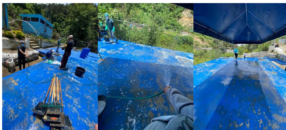
Figura 87A. Limpieza de instalaciones.
