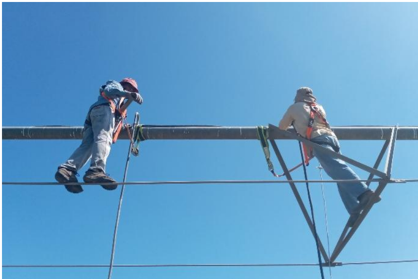
Figura 34A. Instalación de la nueva cartilla de aspersión al pivote central.
