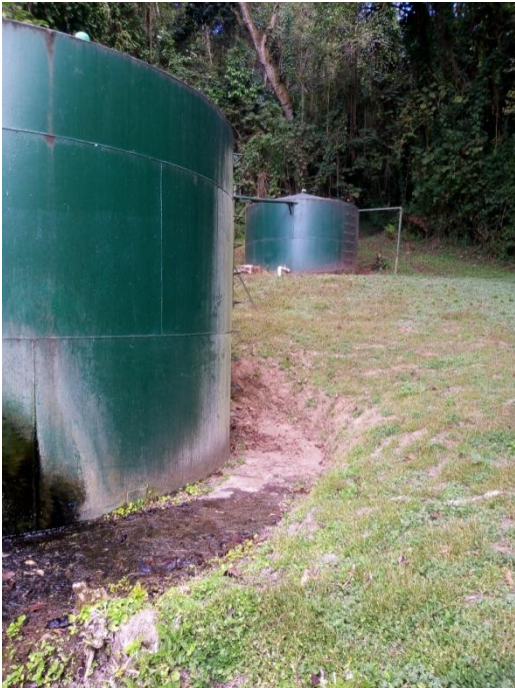
Figura 75A: Tinacos; Punto de extracción de Recurso hacia Choacorrall
