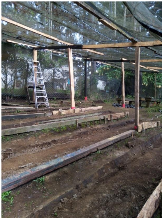
Figura 22A: Área de vivero después de remodelación
