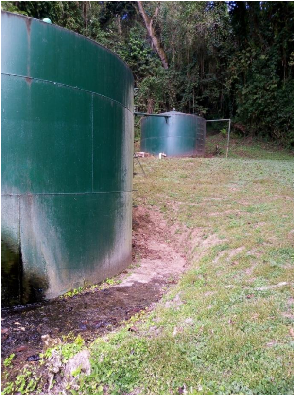
Figura 12: Aprovechamiento de nacimiento de agua.
