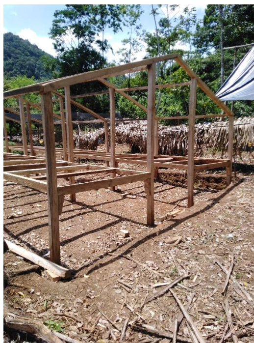
Figura 23 Estructura de madera finalizada
