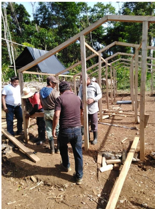
Figura 22. Apoyo de los pobladores en la construcción
