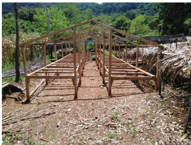
Figura 21 Estructura de la secadora solar
