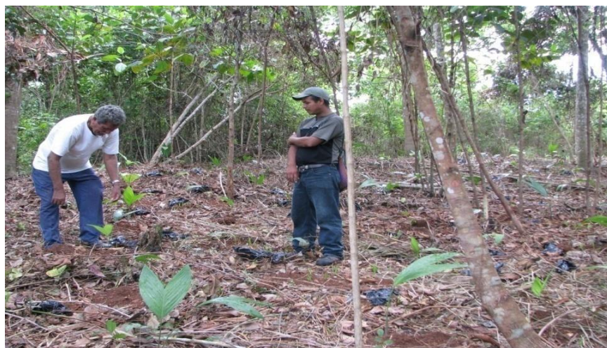
Figura 42. Limpieza del área para la construcción de la secadora solar en la aldea Setzi.
