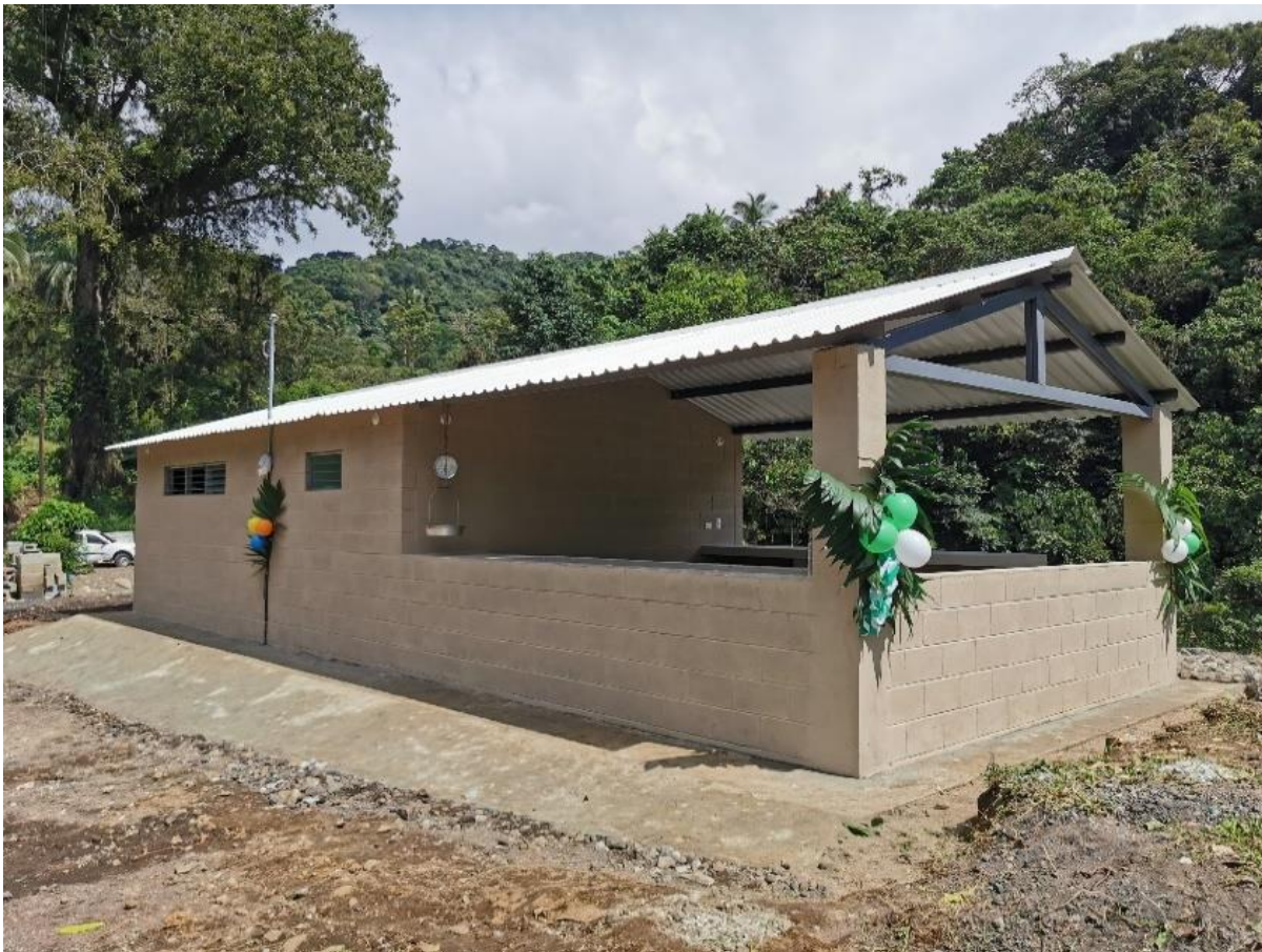
Figura 101. Supervisión de la correcta construcción y distribución de los complementos en la parte externa de la infraestructura.
