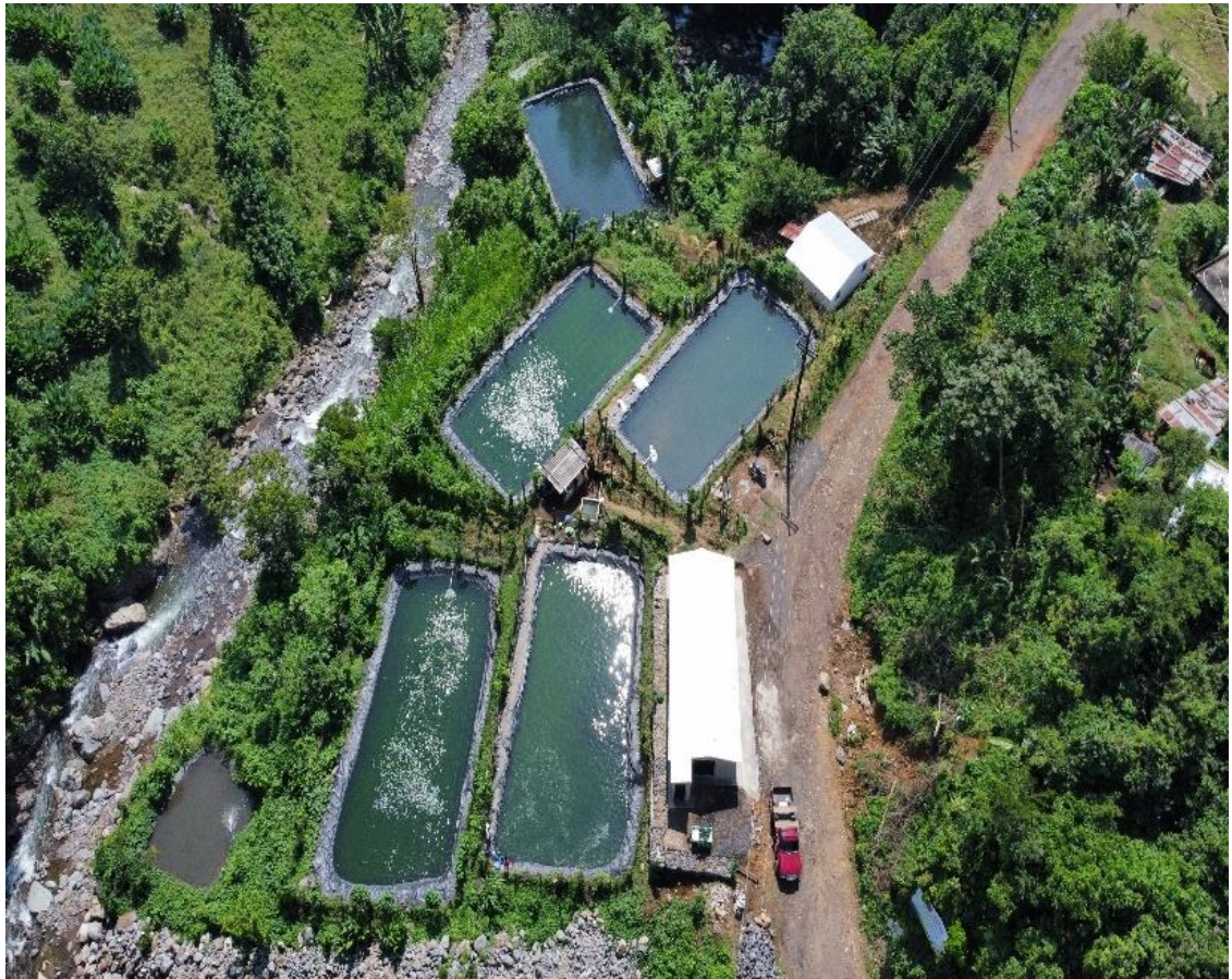
Figura 122. Vista aéreo del proyecto total de la acuícola de tilapia en la finca de El Tabacal, Escuintla.
