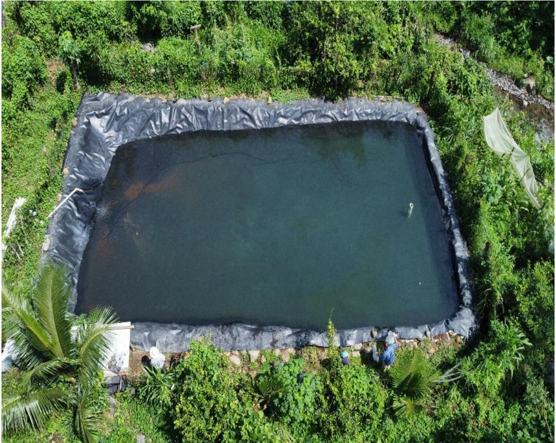
Figura 120. Vista aérea de geomembrana del proyecto.
