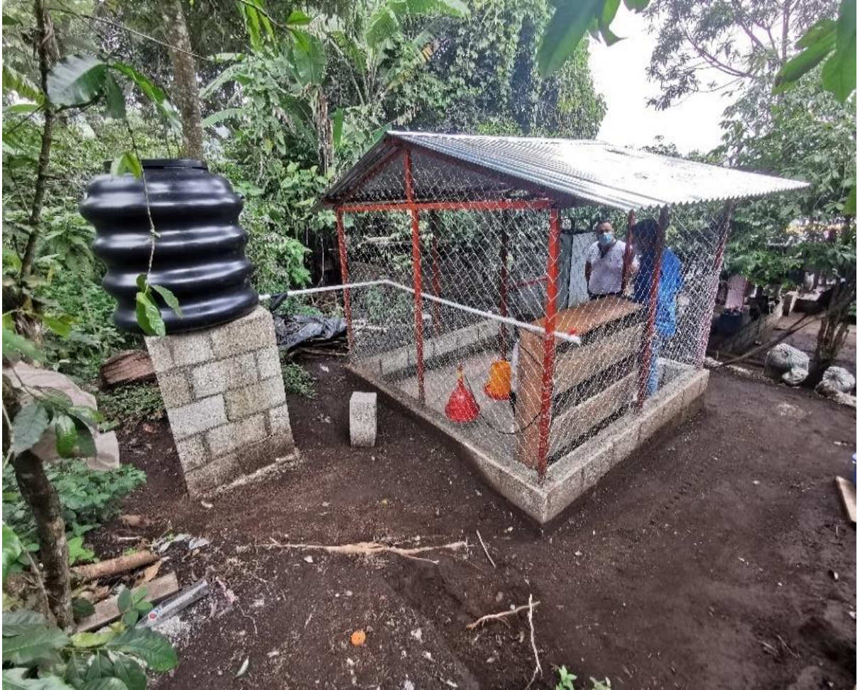
Figura 78. Supervisión en la construcción de los gallineros y en los complementos (comedero, bebedero y nido) y el sistema de agua.
