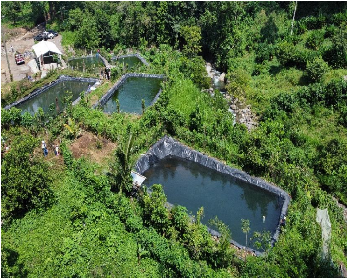
Figura 121. Vista aérea de geomembranas del proyecto.
