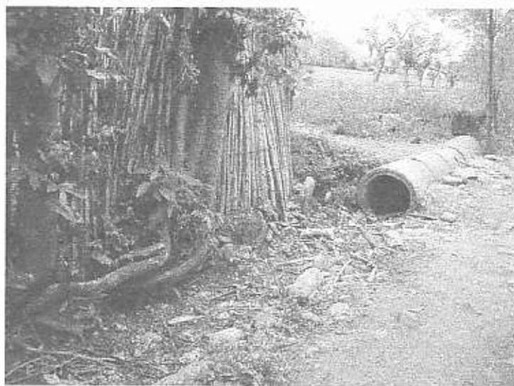
Figura 3. Canal de distribución con tubería de concreto
